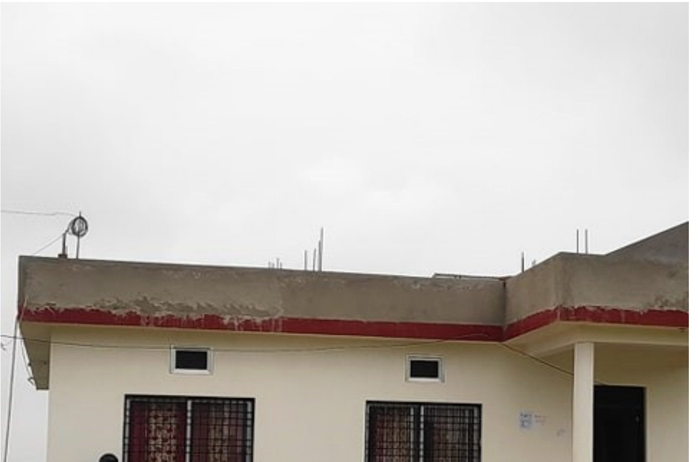
वडा कार्यालय भवन
